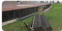
축제장 시설 파손
